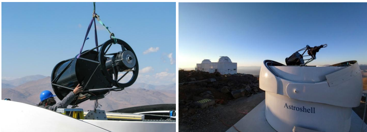
A sinistra, una fase dell'installazione del Test-Bed Telescope 2 all'Osservatorio di La Silla dell'ESO (Crediti: P. Sinclaire/ESO). A destra, la cupola aperta del Test-Bed Telescope 2. Crediti: F. Ocaña/J. Isabel/Quasar SR
